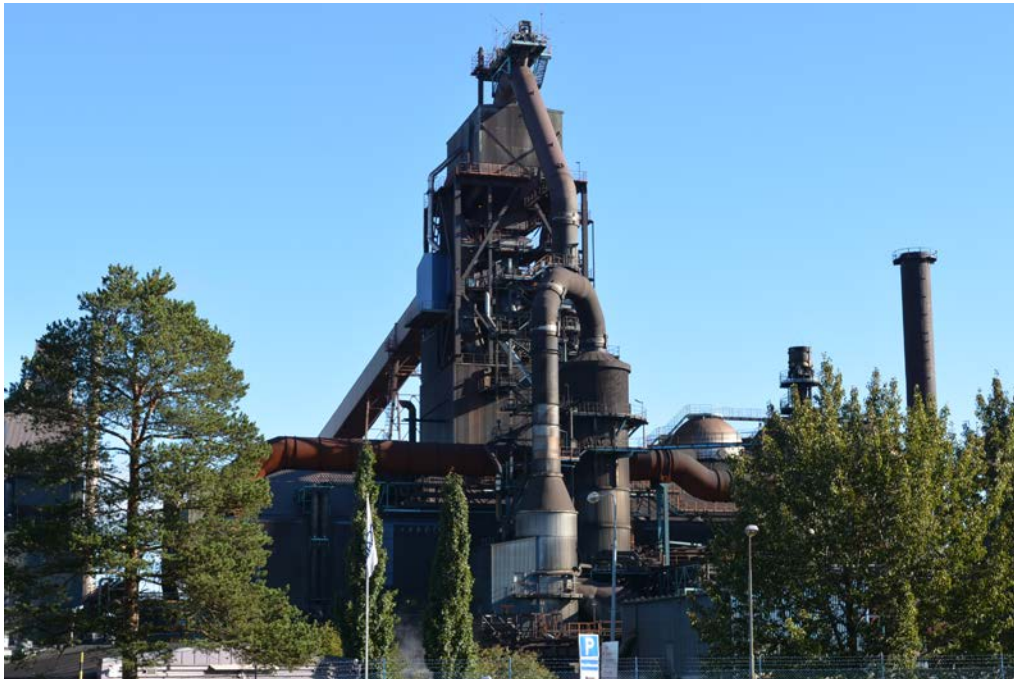
(SSAB_Lulea_copyright_SSAB.jpg) Stahlwerk von SSAB im schwedischen Luleå: Der Einsatz als Hochofengebläse stellt hier besondere Anforderungen an die Kompressortechnologie.
